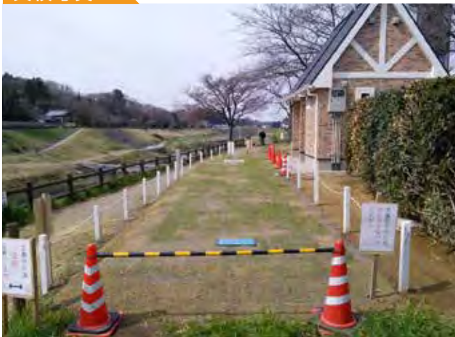
トイレ建屋、土壌浸潤槽
