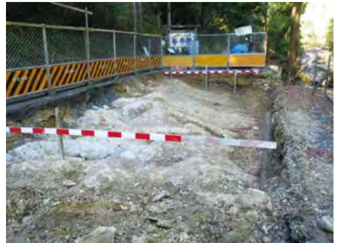
岩盤状況(施工前)
