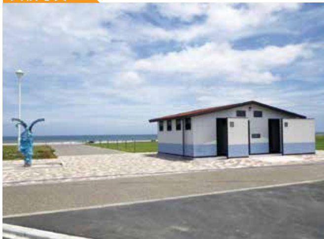
トイレ建屋・シャワー
