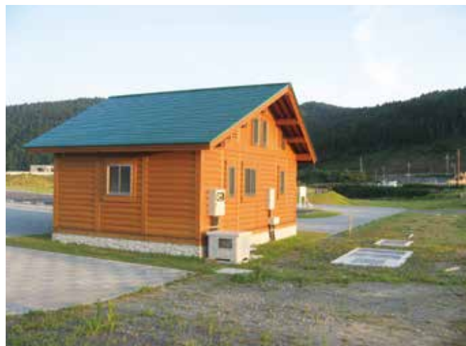
一次処理槽、消毒・貯留槽、土壤浸潤槽
