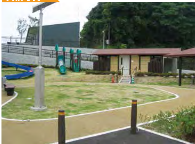
土壤浸潤槽 施工状況
