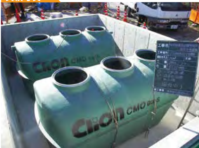
FRP槽施工状況
