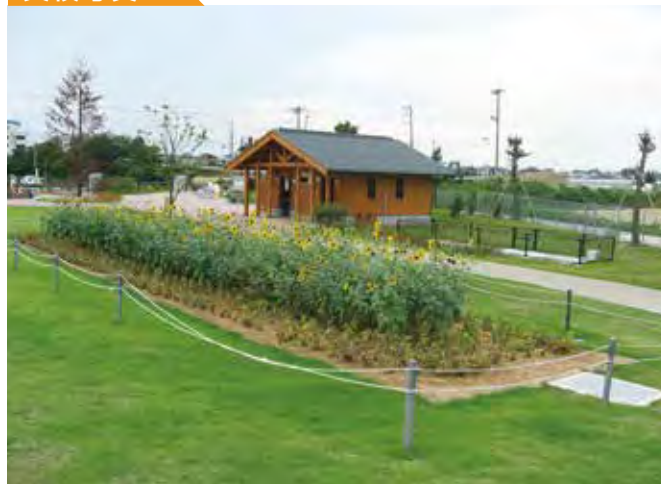
手前：土壌浸潤槽
